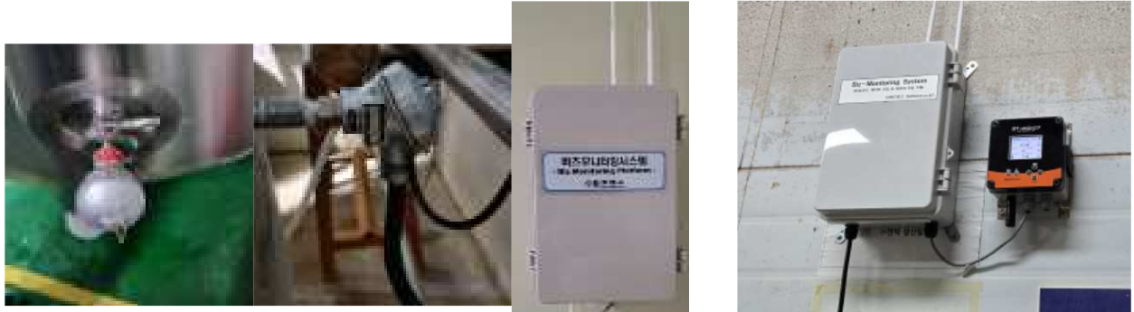
[온도 센서/환경 센서 및 전송 모듈 설치 모습]
