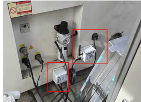
[진동센서 및 전류 센서 설치 모습]
