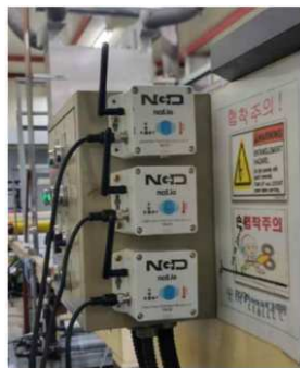
[진동센서 설치 모습]
